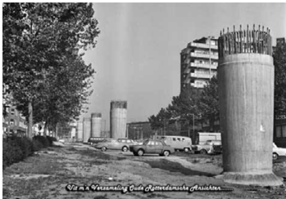
Kolom-kolom Metro 'Di Atas Tanah' yang baru di The Mijnsheerenlaan pada tahun 1965. The Columns of the New 'Above the Ground' Metro at The Mijnsheerenlaan in 1965.
